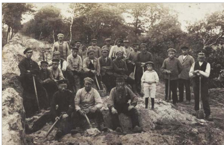
Der Ausbau des Heerwegs nach Friedeburg (B 436) in den 1880er Jahren in Höhe Wiesederfehn. Foto: Hinrich Schumacher †, Wiesede, dessen Vorfahren am Bau dieser Straße beteiligt waren.
